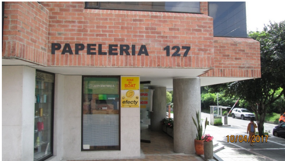
Fotografías No. 1 y 2: Avisos del establecimiento comercial PAPELERIA 127, No cuentan con Registro de Publicidad Exterior Visual, ubicado en la Avenida Calle 127 No. 13 – 96 Local 1.
